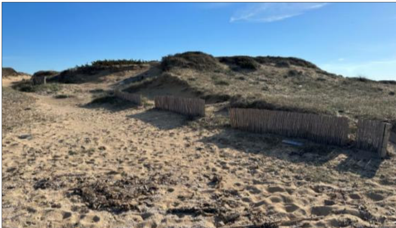
Foto 20 – Interventi finalizzati al ripristino e alla protezione del sistema dunale stabilizzato e semistabilizzato
