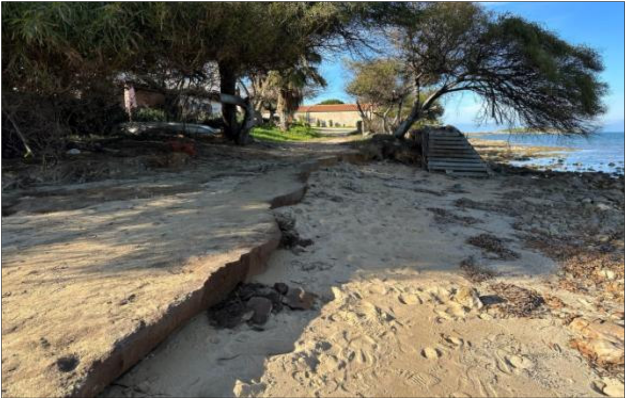
Foto 26 - Dettaglio della ripa di erosione a seguito degli interventi, temporanei, di messa in sicurezza e protezione della linea costiera (gennaio 2024)
